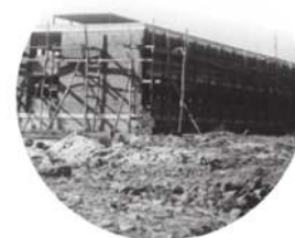
Construcción de La Platina
