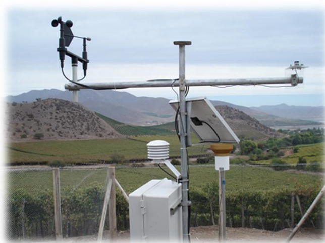
Figura 37: Estación meteorológica automática
