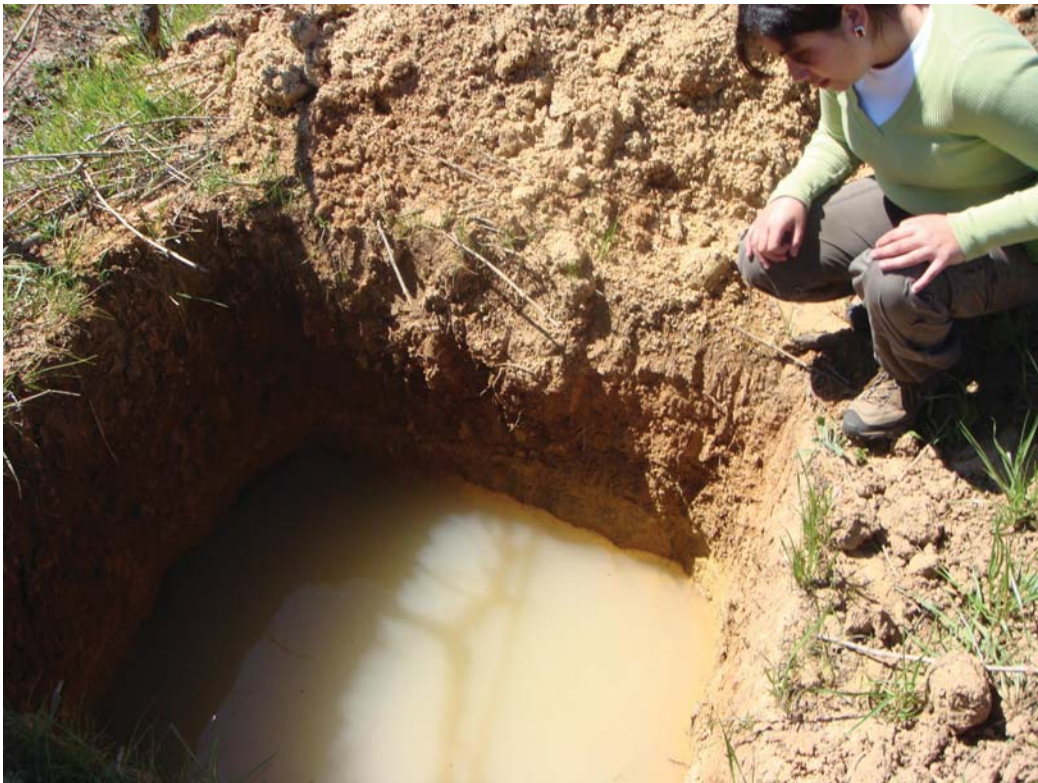
Foto 3. Calicata que muestra problemas de drenaje en el subsuelo. Obsérvese el espejo de agua que indica acumulación. Santa Ana, La Raya, Cauquenes, Región del Maule.
